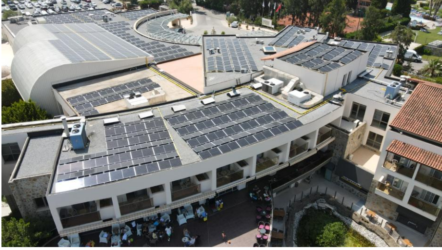
Güneş panelleri ve Elektrik panelleri
